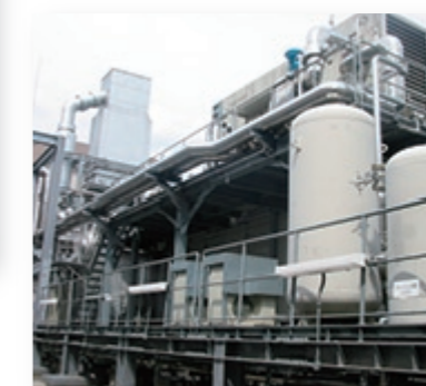
和光キャンパスのコージェネレーションシステム設備。
