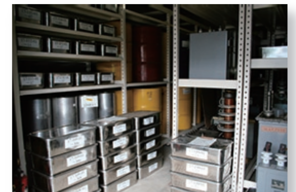
漏洩対策などの措置を行い保管しているPCB含有廃棄物。
