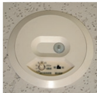
トイレと一部の廊下の天井に設置されている人感センサー。
