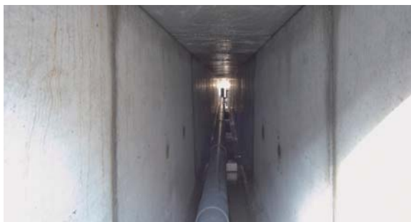
トレンチ内配管
