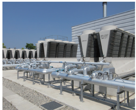
動力棟熱源機器更新
