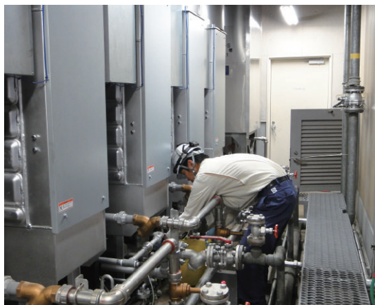
蒸気ボイラーの定期点検の様子
