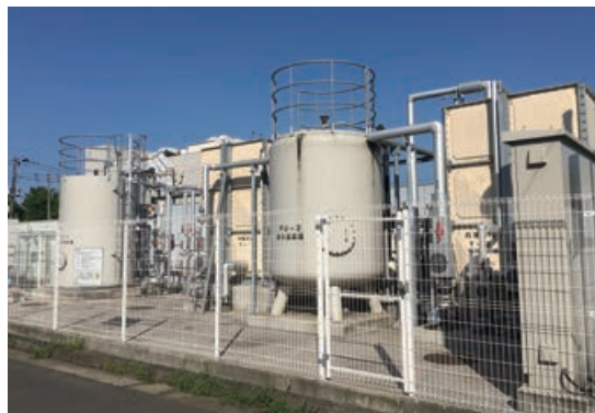
地下水給水装置の設置
