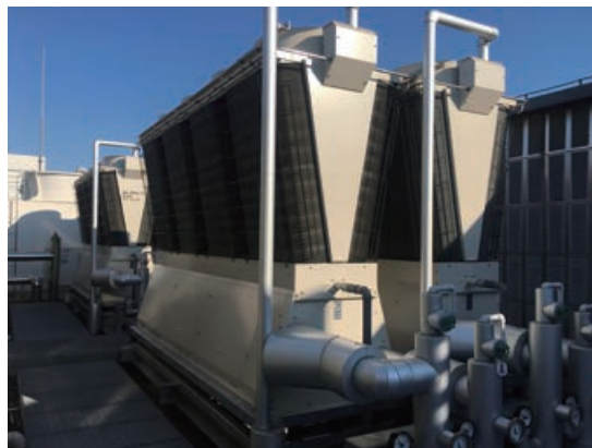
空冷式チラーユニットの更新
