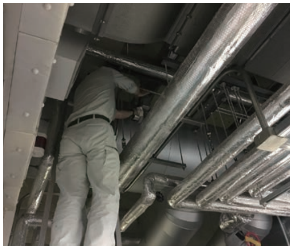
ばい煙濃度計定期清掃の様子
