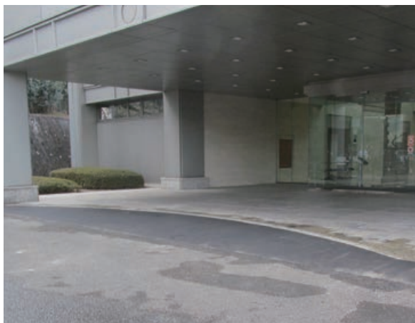
縁石部分の段差をなくしたエントランス
