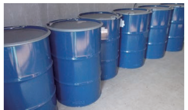
漏洩対策などの措置を行い保管しているPCB含有廃棄物
