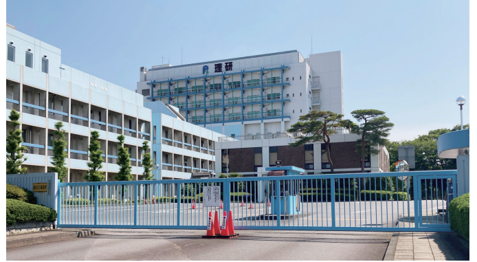
■改修塗装後の正門の様子
