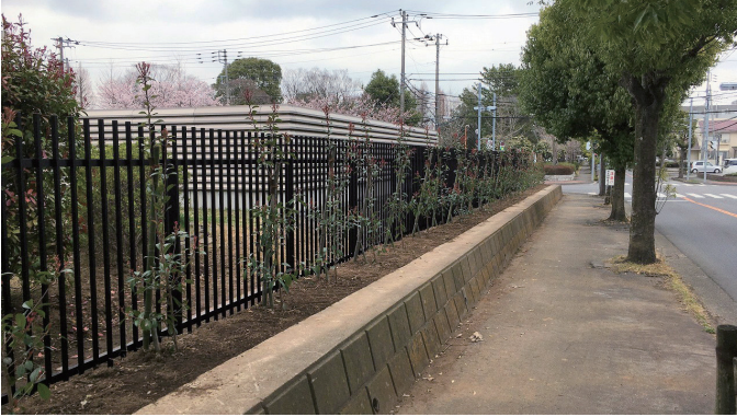
■更新後の外周柵の様子
