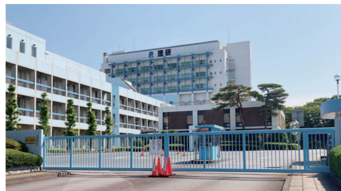
■改修塗装後の正門の様子
