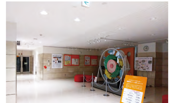
照明のLED化および点灯数の削減
