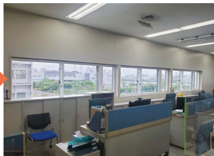
②二重サッシ設置後
