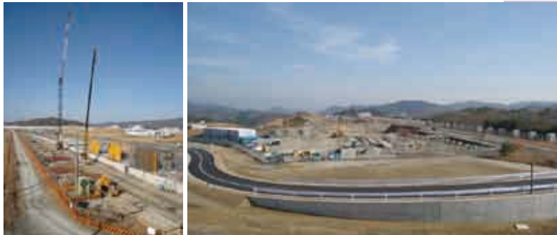
建設中の XFEL 施設
