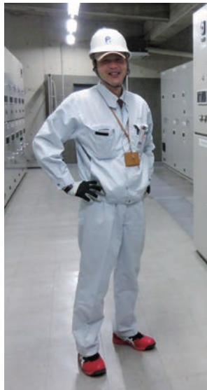
写真1 ● 筆者近影。電気設備のメンテナンス作業中。
