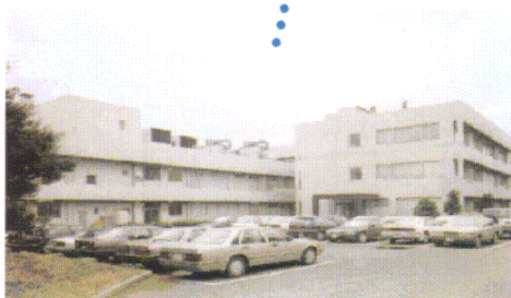
思考機能研究棟(西研究棟)(West Building) ・完成年：平成3年6月
