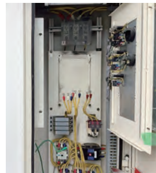
インバータ取替工事の様子
