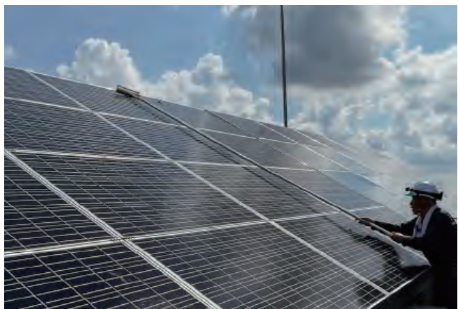
太陽光パネルの点検・清掃を実施
