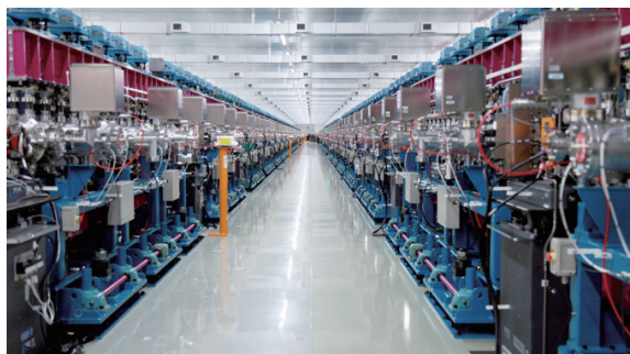
SACLA内部 真空封止アンジュレータ
