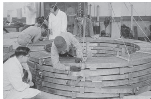
大サイクロトロン電磁石用コイルの組み立て
