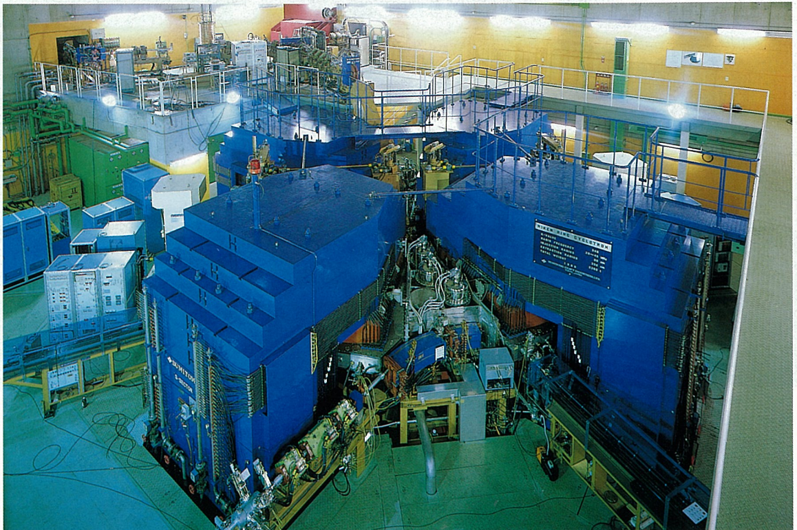
図1 リングサイクロトロン(昭和61年完成)
