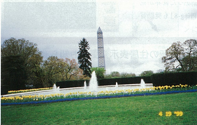
ワシントン・モニュメント（改装中で青い枠組みで覆われている）
