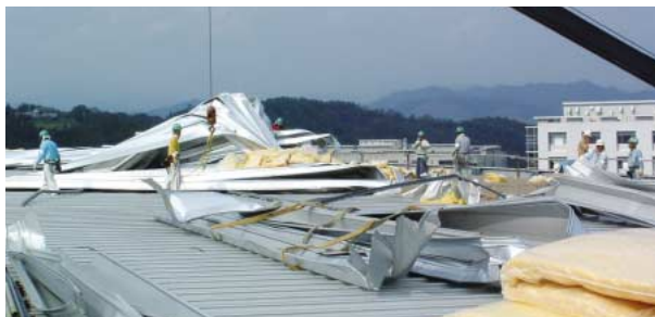
台風18号直後の蓄積リング棟屋根(2004年9月)
