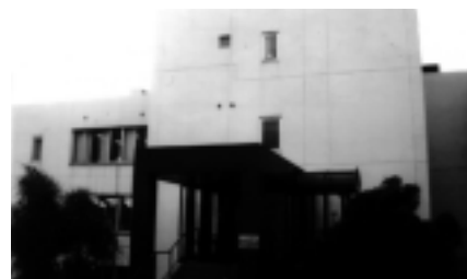
フロンティア研究システム棟
