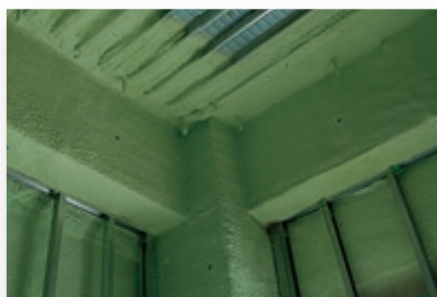
建設途中の建物。吹き付けてある断熱材。
