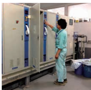
水質自動監視装置
