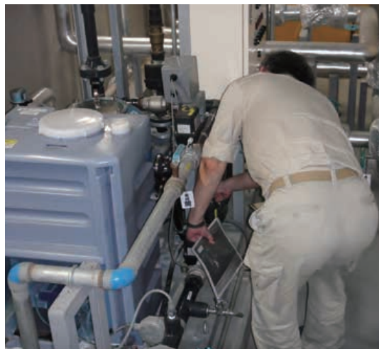
排水設備の日常点検の様子
