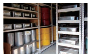
漏洩対策などの措置を行い保管している PCB含有廃棄物保管庫
