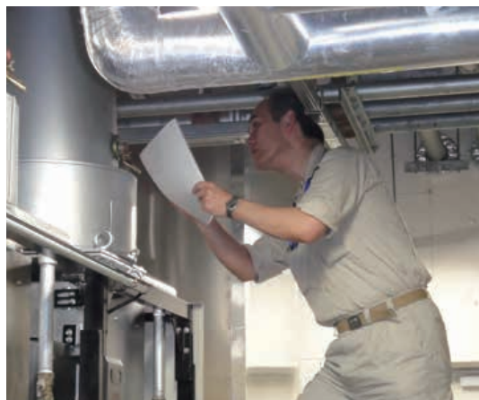
ボイラー設備の日常点検の様子
