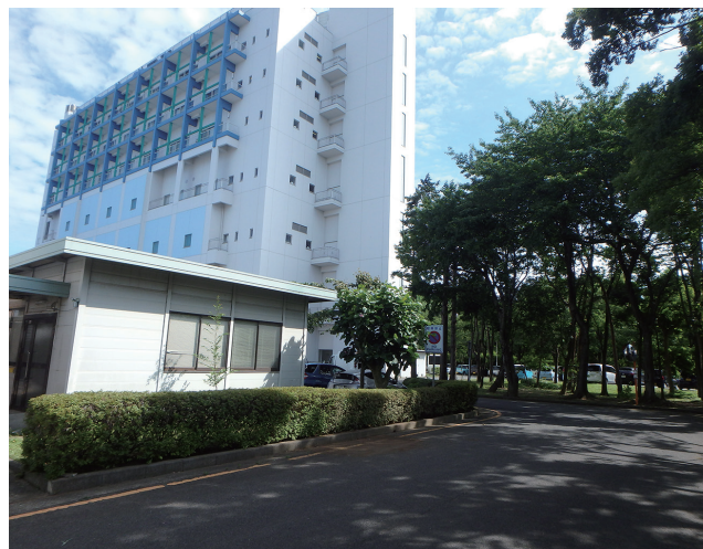
バイオリソース棟付近の中高木管理状況
