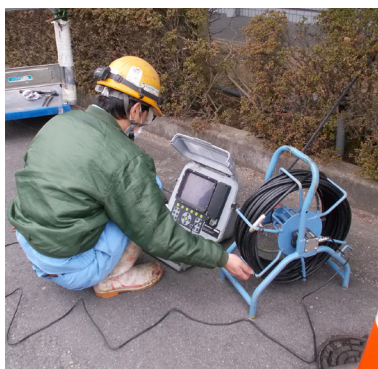
漏水検査作業の様子
