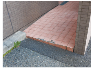
(C棟改修前)
