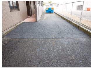
(C棟改修後全景)
