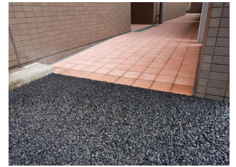
(C棟改修後)
