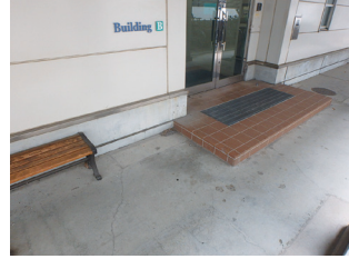
(B棟改修前)
