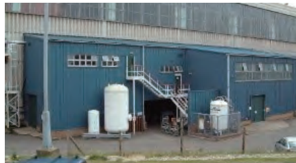
コンプレッサー建屋
